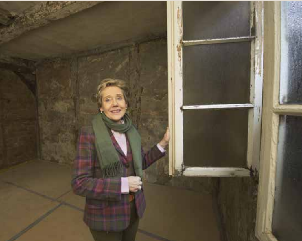
Von der früheren Pracht ist zur Zeit nicht viel übrig geblieben. Dafür wird es nach der Sanierung um so schöner und wärmer in Frau Bades Haus
