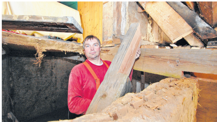
Zimmerer Matthias Kiemann muss die Balkenkonstruktion des Daches stabilisieren.
